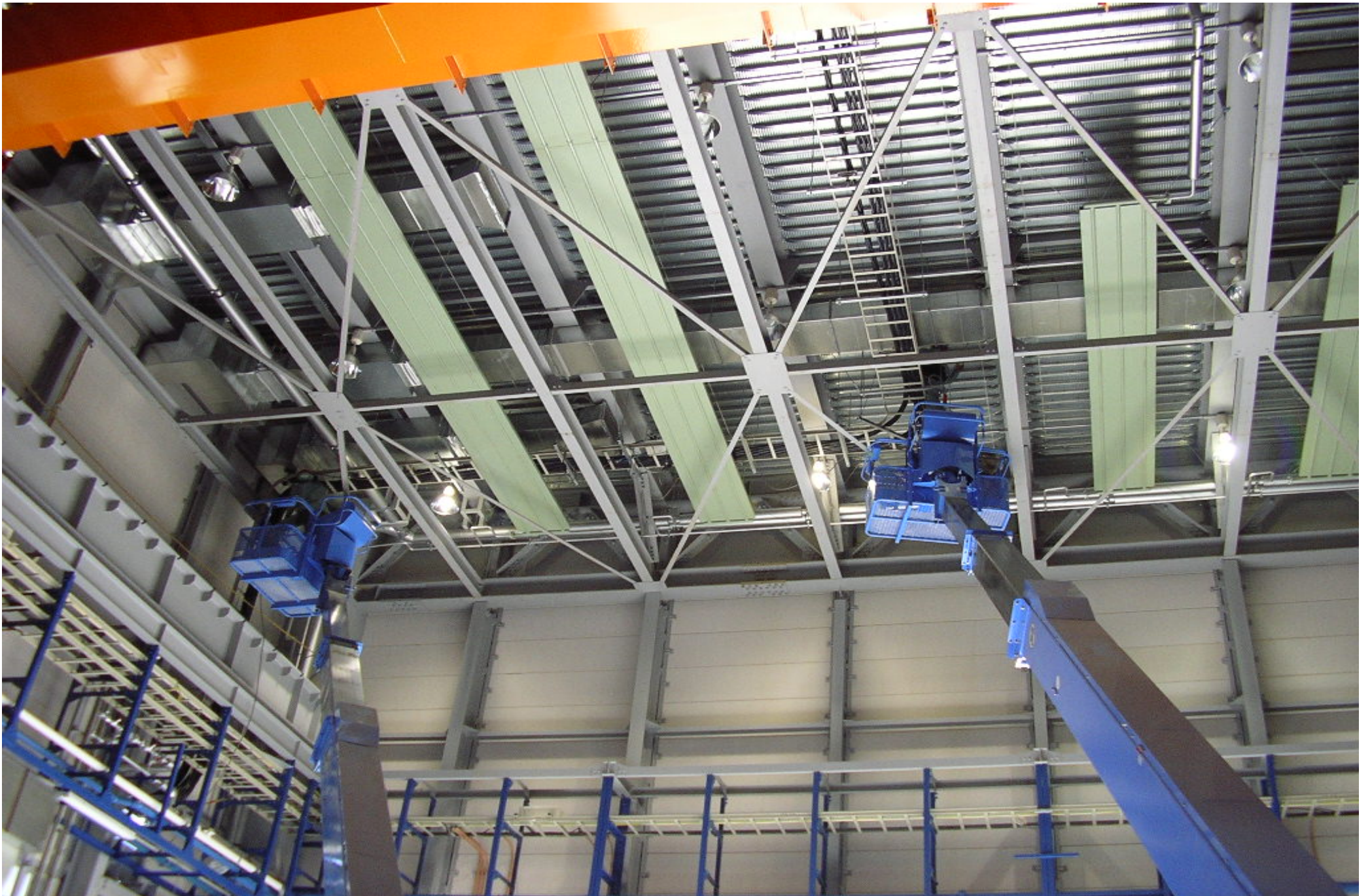
高圧幹線ケーブル布設工事(高さ18m) (株ダイダン 日阪製作所(東大阪)6KV-CVT-150
