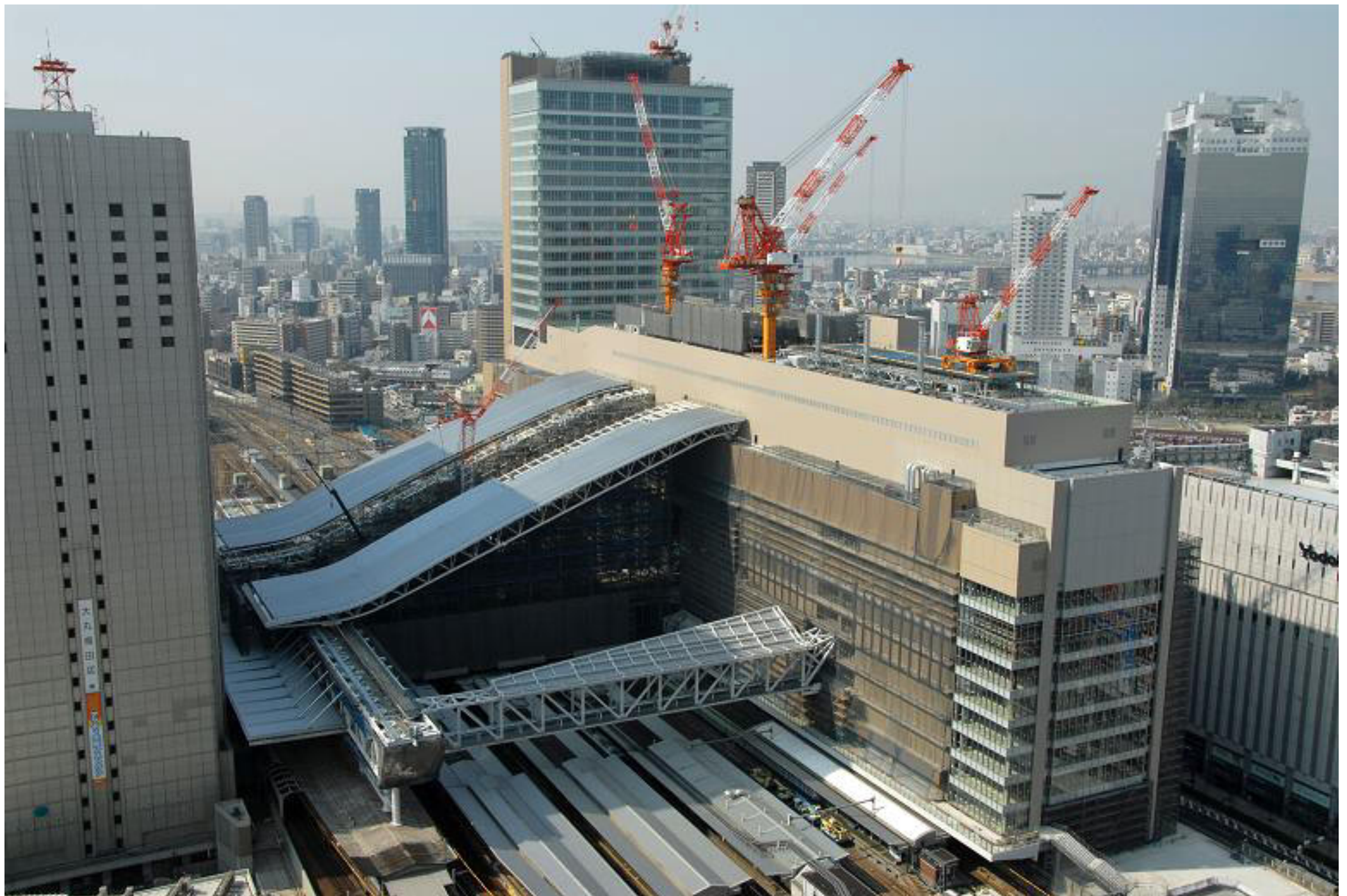
JR大阪駅新北ビル新築工事及び周辺工事 平成21年3月1日～共同電設も参加
