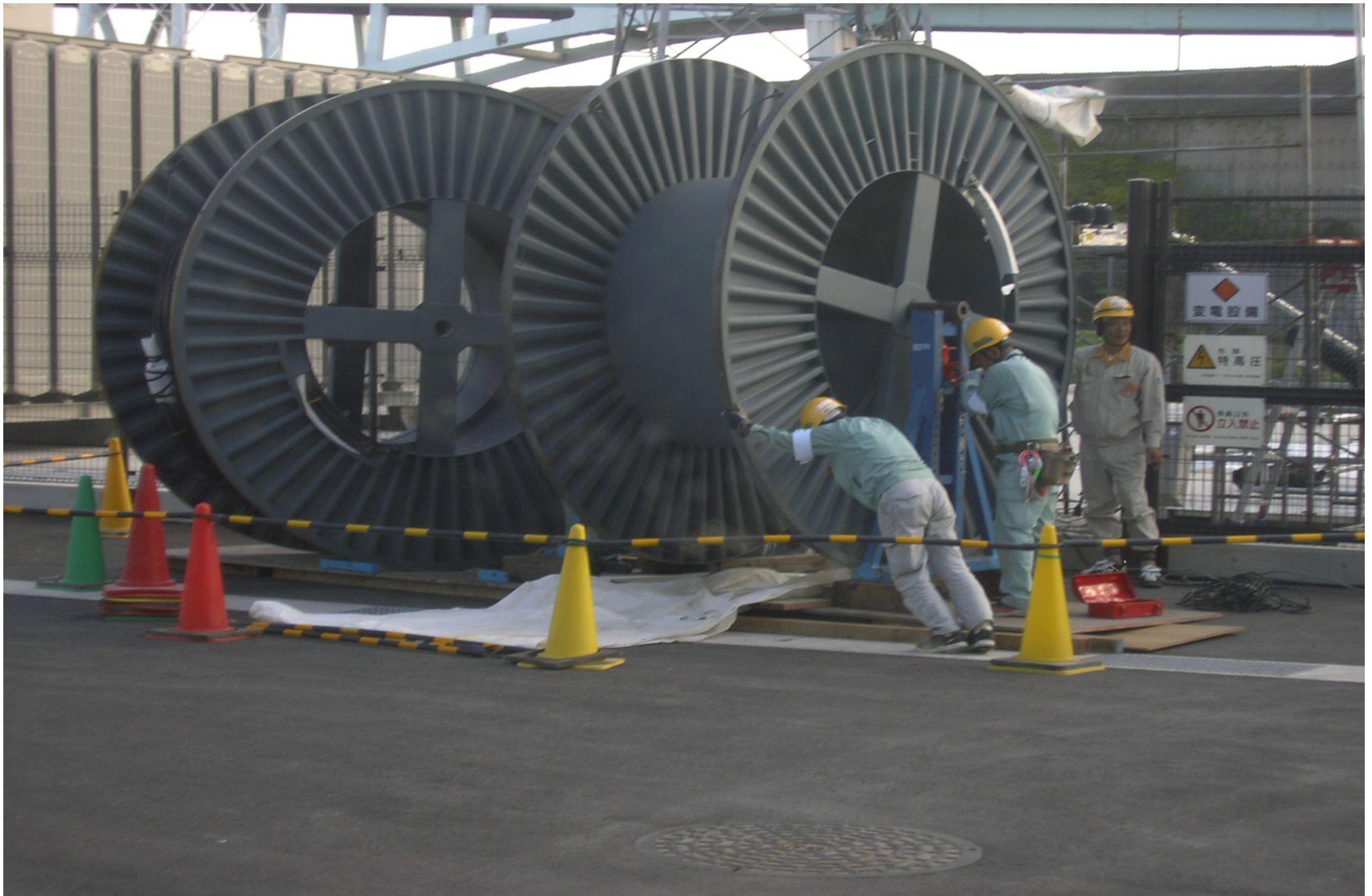
パナソニック エナジー社 住之江工場 高圧幹線ケーブル (H21.10.5~10.20) 6KV-C 6KV-CVT500° -450m ノージョイント (栗原工業株)
