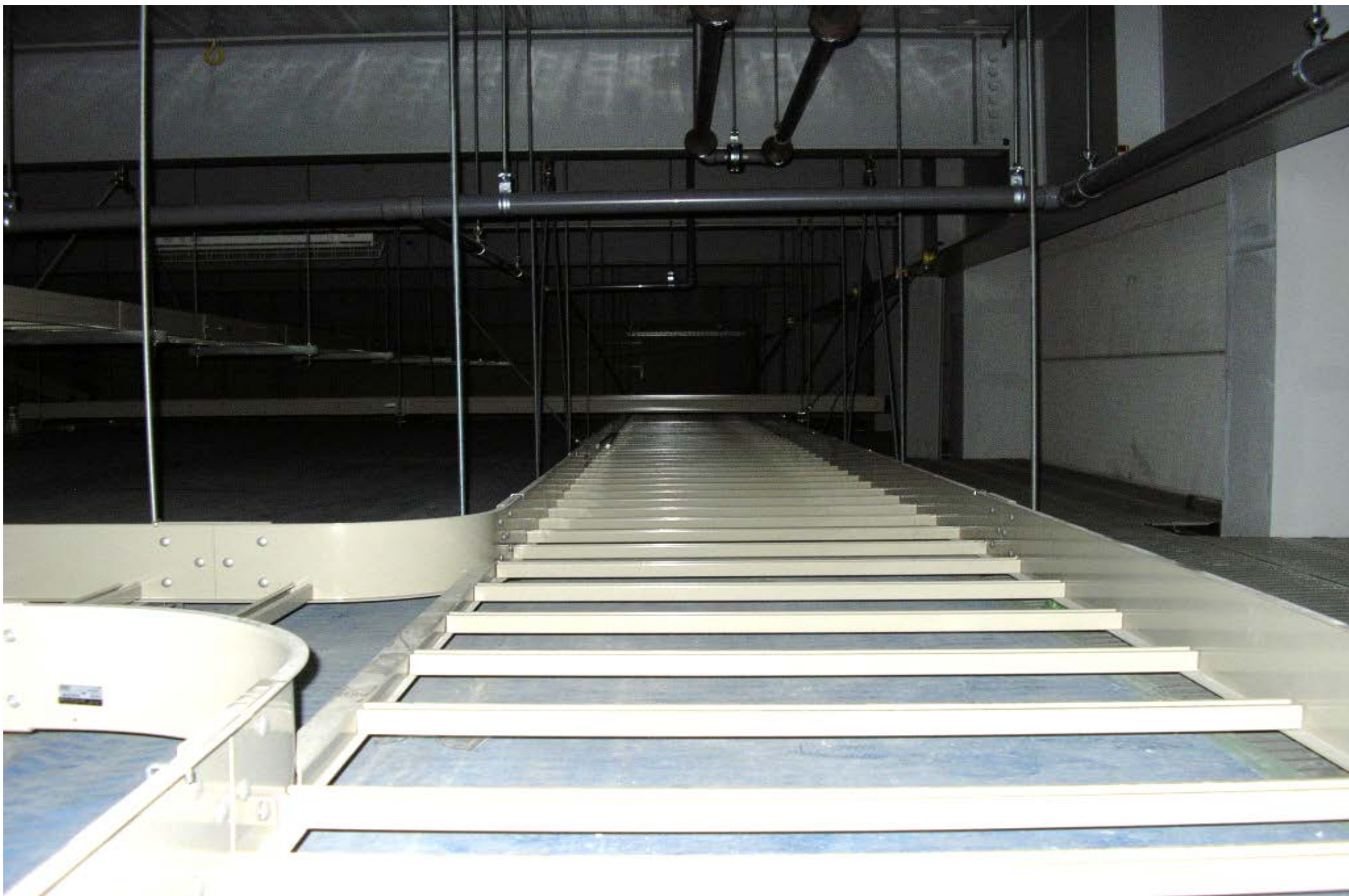
パナソニック尼崎PDP5高圧幹線ケーブルラック工事
