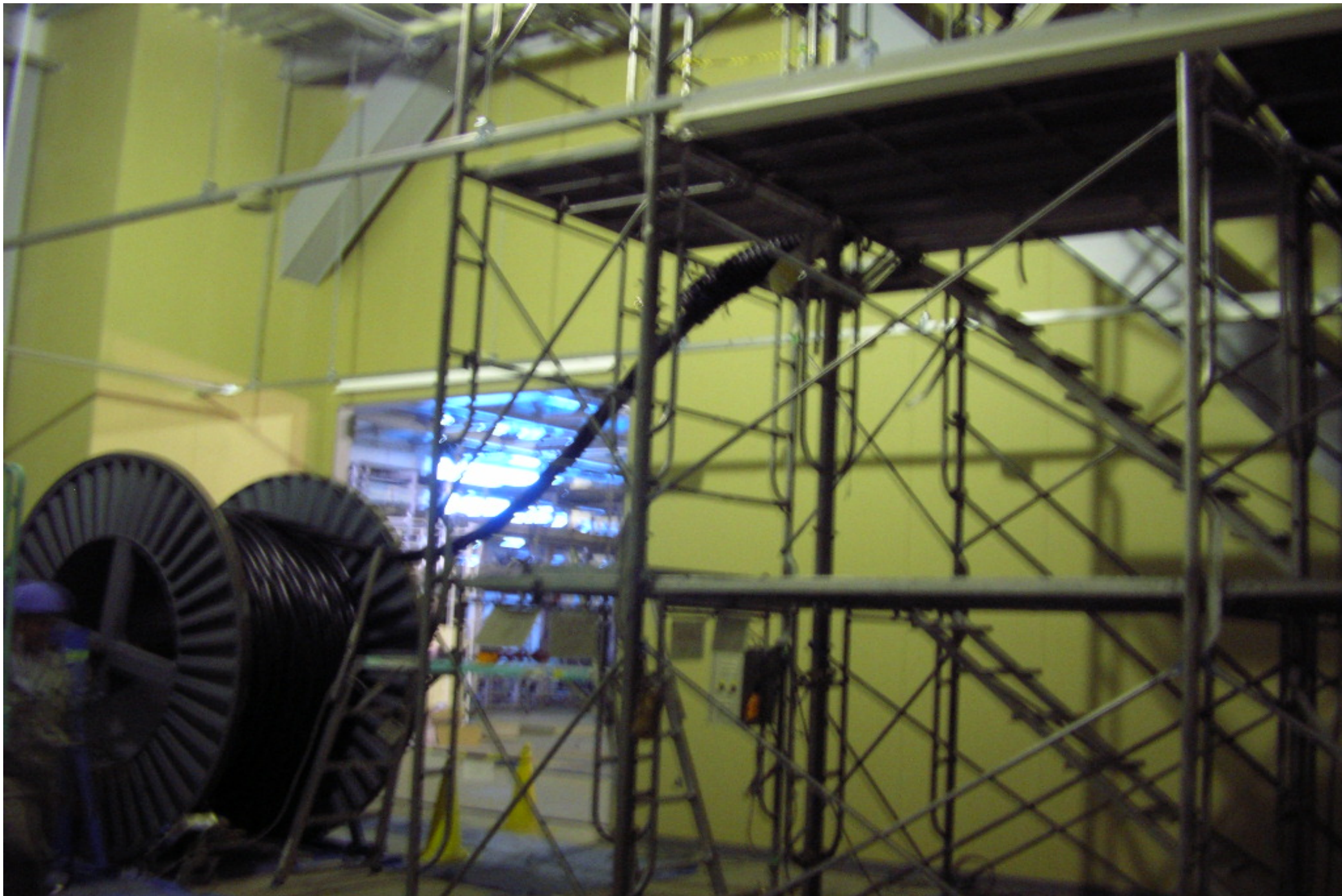
パナソニック尼崎PDP5高圧幹線ケーブル布設工事 6KV-CVT500～600m/m
